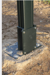
Fästplatta på gjuten plint.
